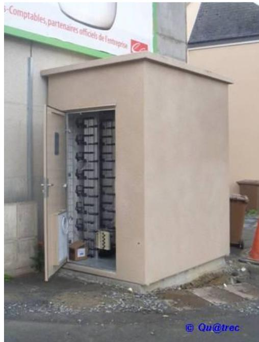
La photo ci-dessous illustre l'exemple d'un PM à Issoire (63), matérialisé par une armoire de rue d'environ 1,6 m (L) x 1,5m (h) x 0,45m (p) permettant l'hébergement de 4 opérateurs.
